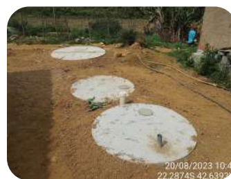
Sistema de tratamento de efluentes domésticos instalado em propriedade da microbacia de Barracão dos Mendes – Nova Friburgo/RJ (Foto: DHF Engenharia - Contrato nº11/2022/AGEVAP)
