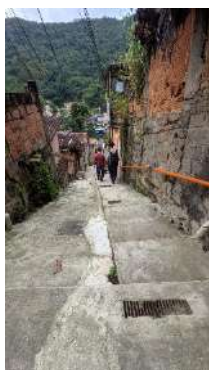
Comunidade dos Cabritos - Esgotamento - CBH-BG. Foto: Leandro Viana/ UD9 -AGEVAP
